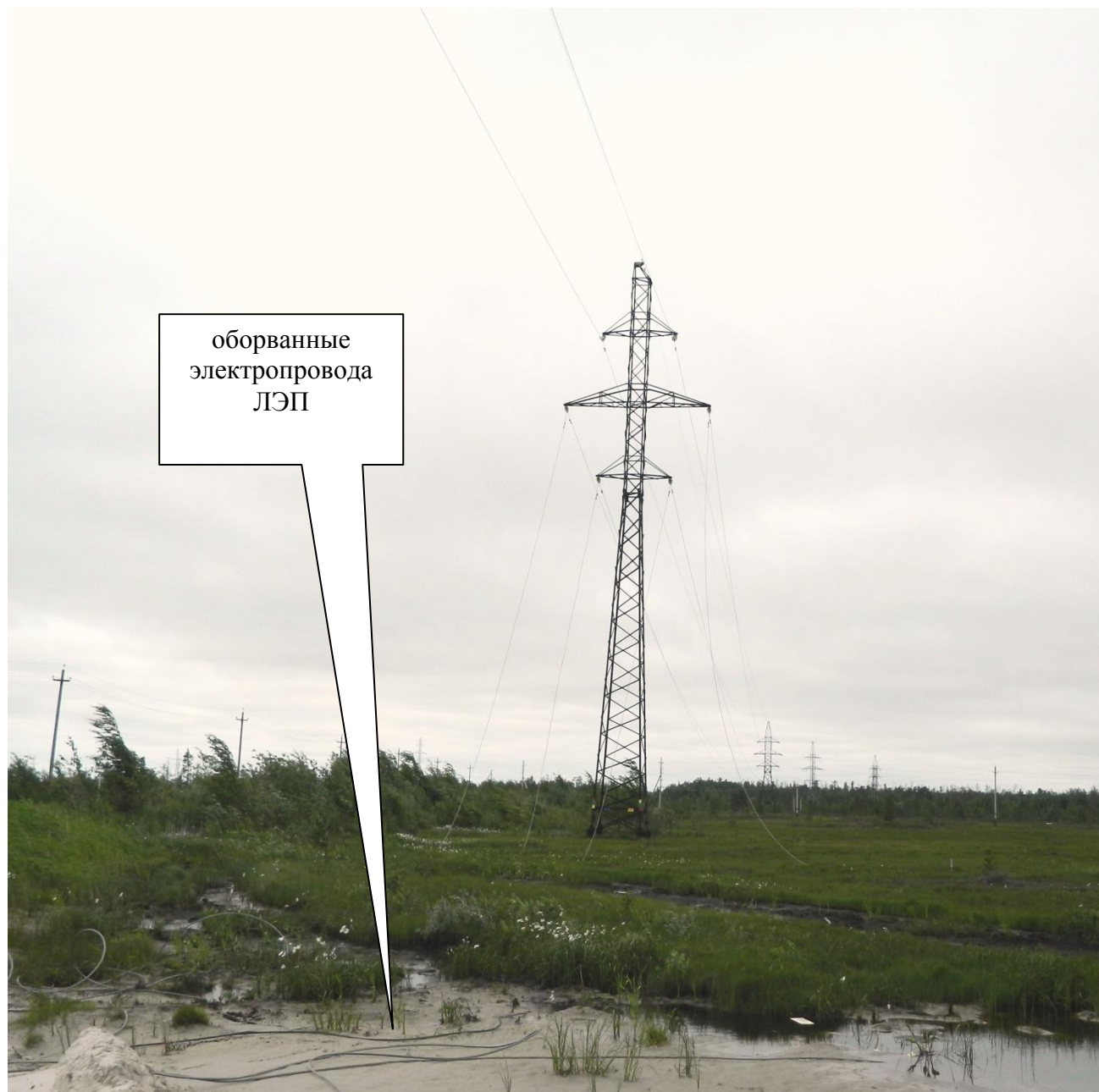
Рис. 5. Вид опоры ЛЭП на месте АП и характер повреждения проводов ЛЭП
